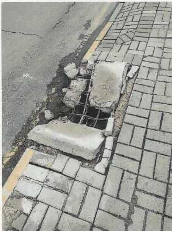
Boca de lobo situada próximo ao número 186
