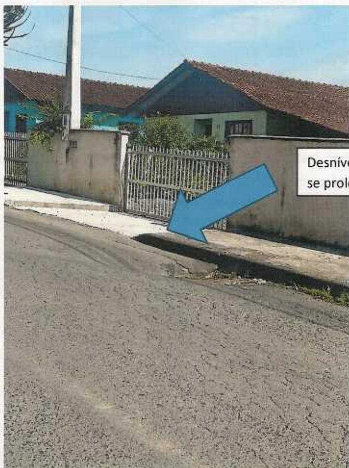
Desnível evidenciado próximo a boca de lobo que se prolonga pelo pavimento asfáltico.
