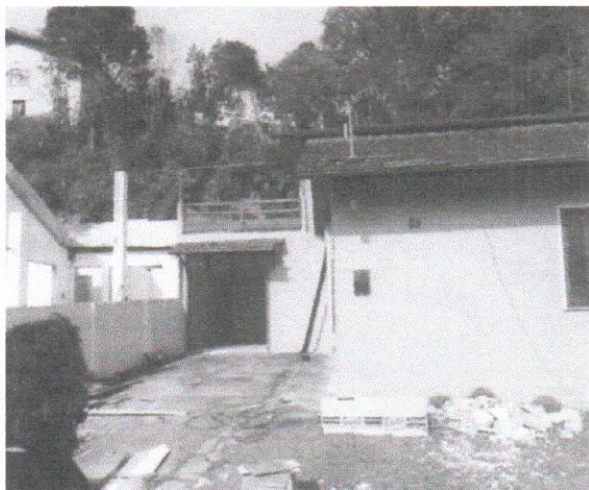
Figura 11. Deslizamento superficial de solo nos fundos do imóvel, não atingiu a estrutura da edificação. (Fonte: extraído de Laudo D.C. de São Bento do Sul n.128/2014, jun. 2014).
