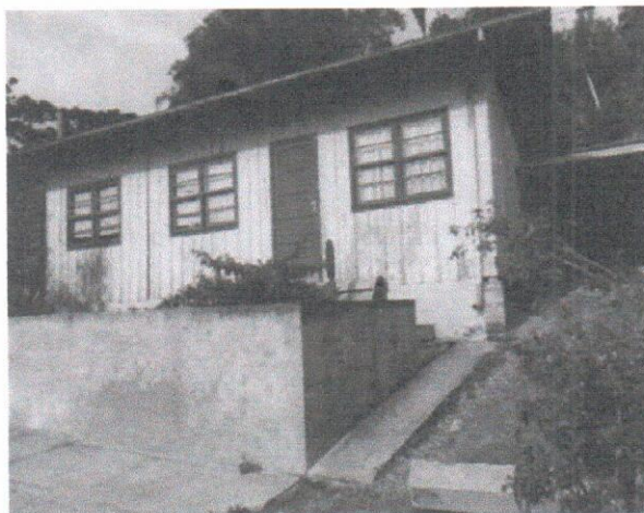
Figura 3. Deslizamento de solo nos fundos do imóvel, não atingiu a estrutura da edificação. (Fonte: extraído de Laudo D.C. de São Bento do Sul n.128/2014, jun. 2014).
