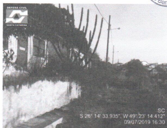
Figura 6. Área frontal à edificação unifamiliar após as obras de recomposição do talude. (Fonte: Defesa Civil Estadual SC, 09/07/19).
