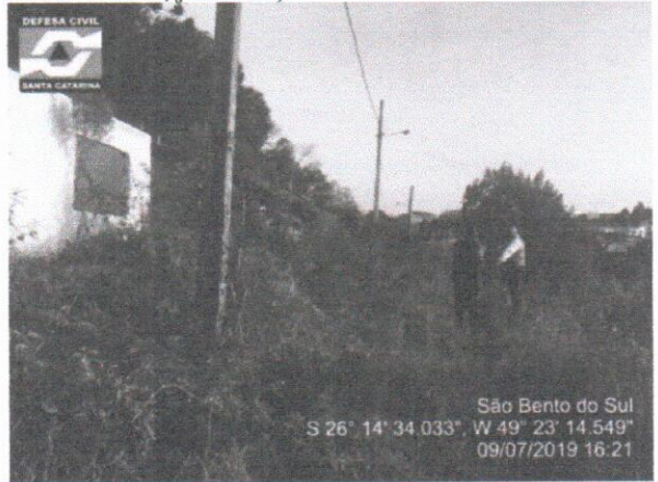
Figura 10. Após as obras realizadas a r. Bárbara Krainski permanece estabilizada e com desenvolvimento de vegetação arbustiva. (Fonte: Defesa Civil Estadual SC, 09/07/19).
