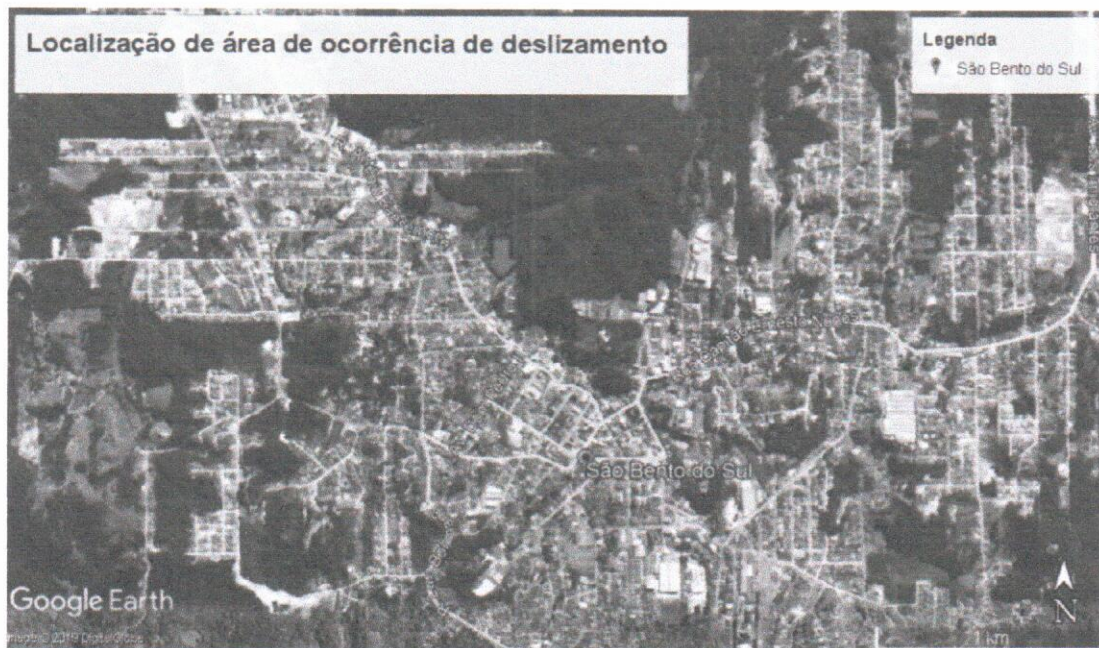
Figura 1: Localização da região e área em que houve deslizamento (indicado pela seta vermelha) em talude de corte de aterro, em via pública e residências unifamiliares, no município de São Bento do Sul/SC.
