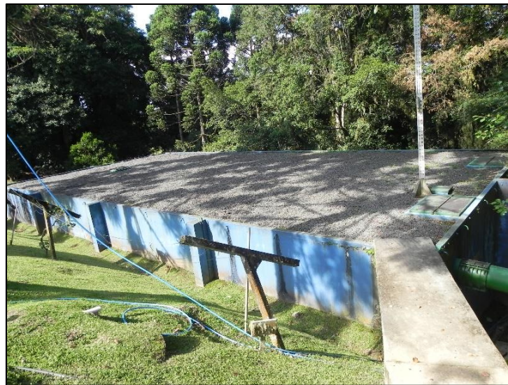
Fonte: Motta Martins Engenharia, 2020.
