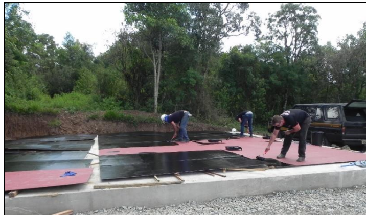
FIGURA 313 – OBRAS DO RESERVATÓRIO – RIO VERMELHO ESTAÇÃO
