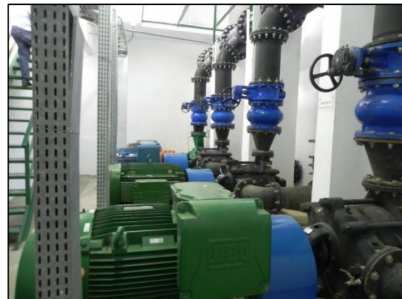
FIGURA 19 – BOMBAS DE RECALQUE DE ÁGUA BRUTA.
