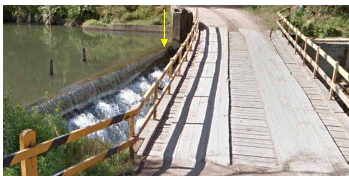
FIGURA 13 – BARRAGEM DE CAPTAÇÃO (A ESQUERDA)
