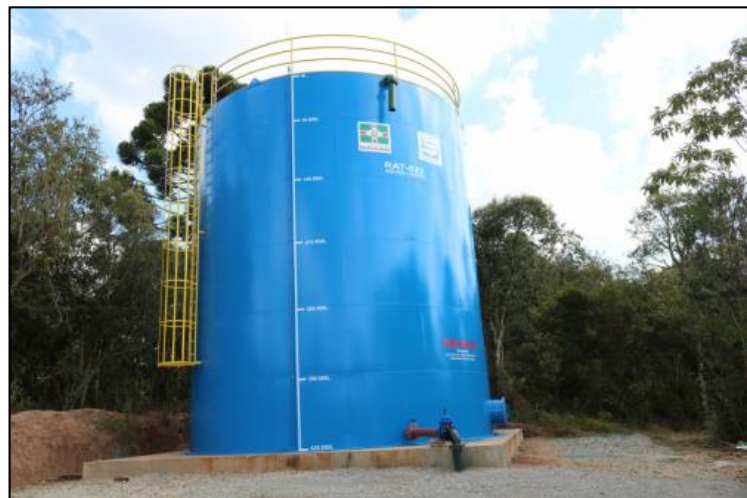
FIGURAS 34 E 35 – CONCLUSÃO DO RESERVATÓRIO – RIO VERMELHO ESTAÇÃO
