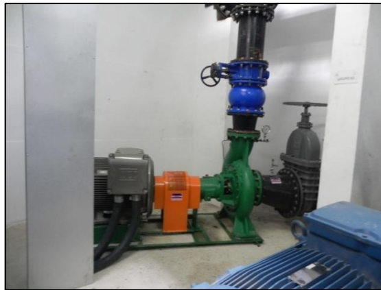
FIGURA 19 – BOMBAS DE RECALQUE DE ÁGUA BRUTA.
