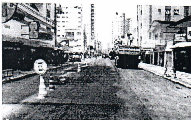
Durante a Construção
