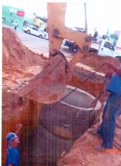
05. 11/03/15 - Execução de P.V DN 1500
