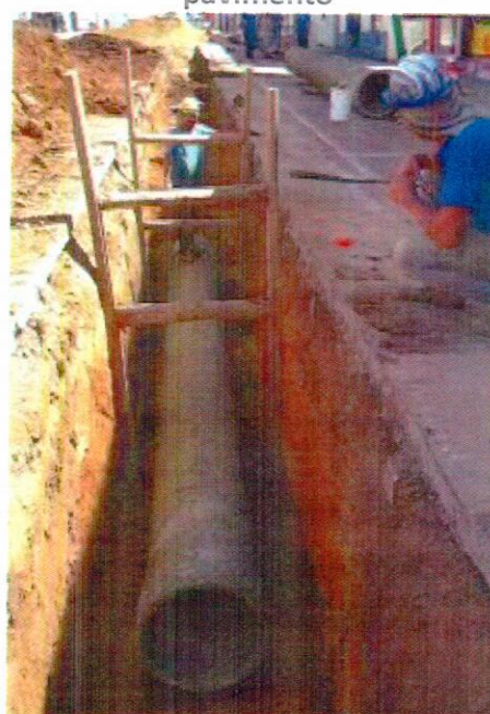
14. 13/03/15 - Assentamento de tubos DN 500
