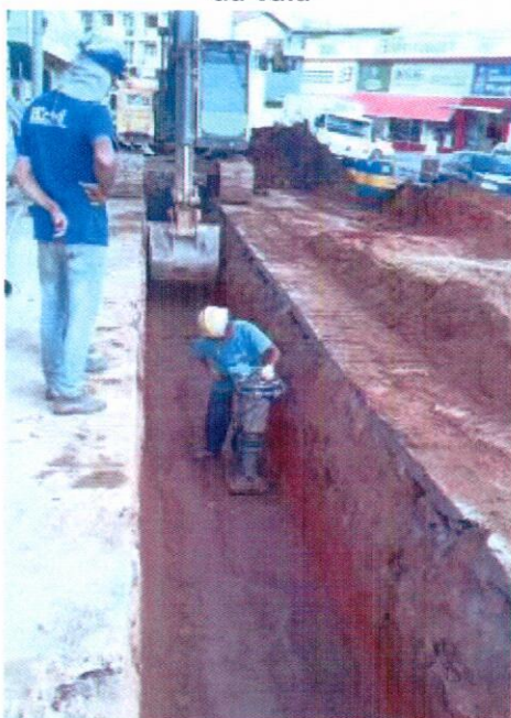
09. 12/03/15 – Compactação mecânica da vala sobre o interceptor para assentamento dos tubos da rede coletora
