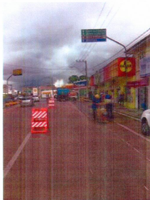
02. 10/03/15 - Sinalização da via e corte de pavimento, Av. Argolo (entre as estacas 13 e 09)
