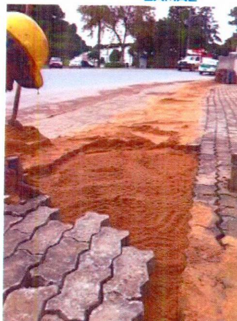
56. 17/04/15 - Recomposição de calçada em paver
