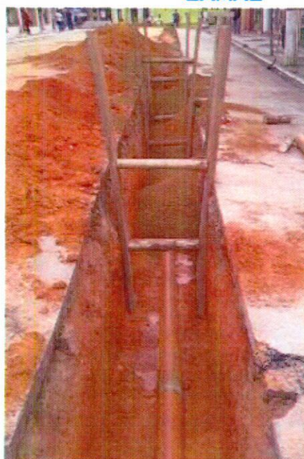
36. 20/03/15 – Assentamento de tubos DN 150 mm com vala escorada e envelopamento com areia
