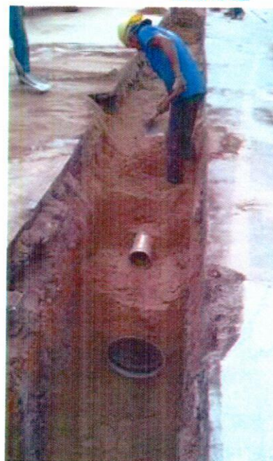
20. 16/03/15 – Assentamento da tubulação DN 400 e DN 150
