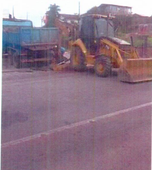
43. 26/03/2015 – Local de escavação
