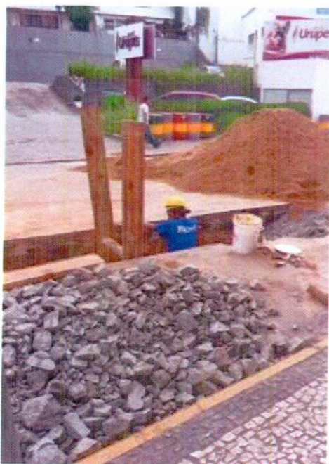
27. 17/03/15 – Escoramento da vala com pontaletes de madeira
