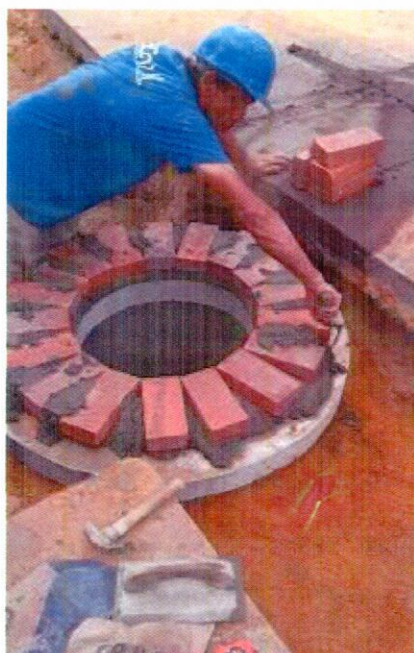
37. 20/03/15 – Execução de nivelamento da tampa do P.V.
