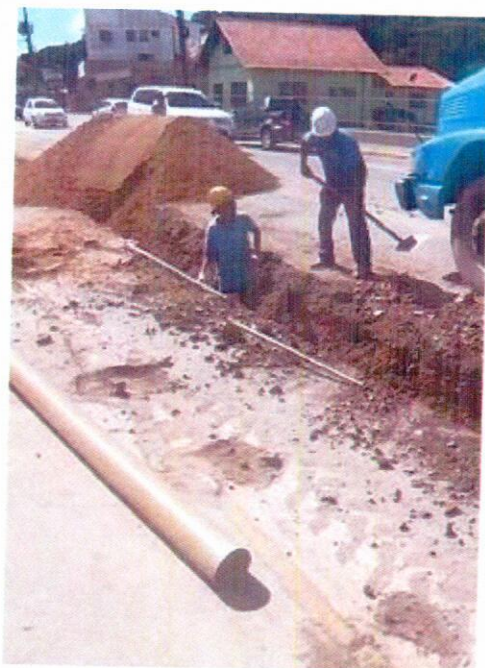
47. 31/03/2015 – Reaterro da vala com areia
