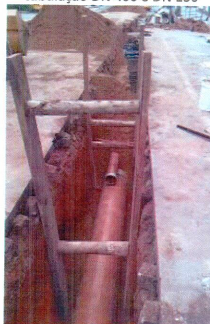
22. 16/03/15 – Assentamento de tubos em vala escorada
