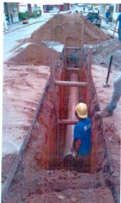
31. 18/03/15 – Assentamento de tubos DN 400mm
