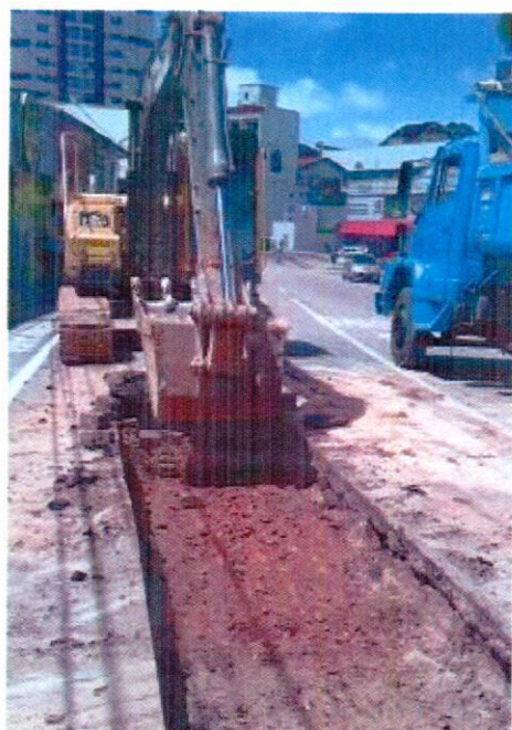
03. 11/03/15 - Remoção de pavimento (entre as estacas 13 e 09)
