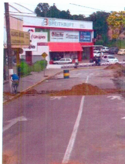
34. 19/03/15 – Execução de ligação domiciliar
