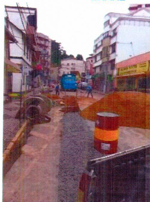
24. 17/03/15 – Vista do local de execução das obras
