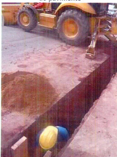
41. 26/03/2015 – Escavação de vala
