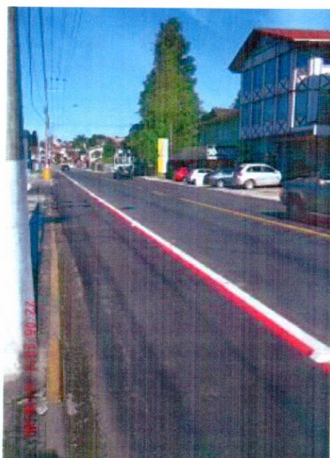
59. 26/06/15 – Finalização da recomposição de pavimento na Rua Antônio Kaesemodel, com sinalização horizontal da via.
