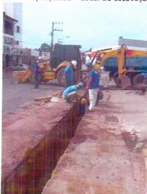
45. 27/03/2015 – Nivelamento do fundo da vala para assentamento da tubulação
