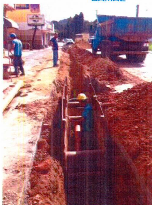
52. 16/04/15 – Escoramento metálico da vala para assentamento da tubulação.
