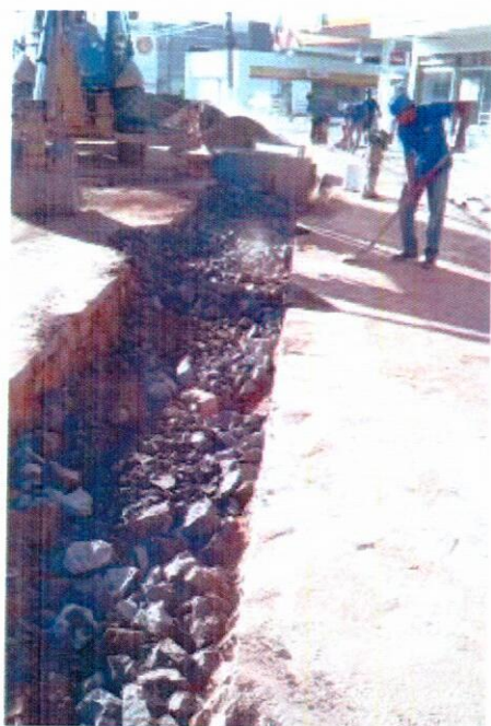
11. 12/03/15 – Recomposição do pavimento
