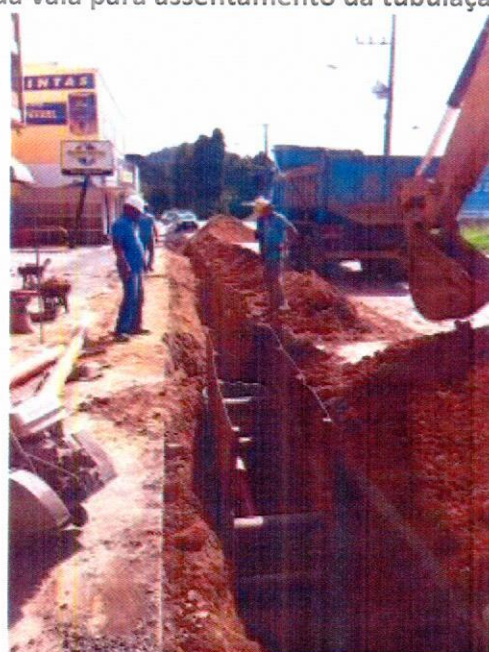
54. 16/04/15 – Assentamento da tubulação em vala escorada.
