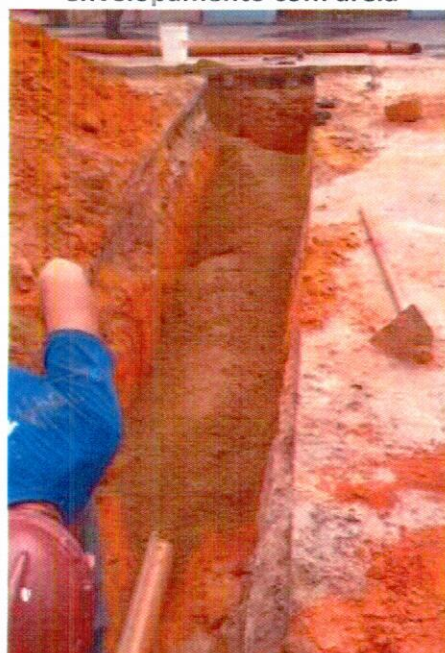
38. 20/03/15 – Envelopamento da tubulação do ramal domiciliar DN 100 mm
