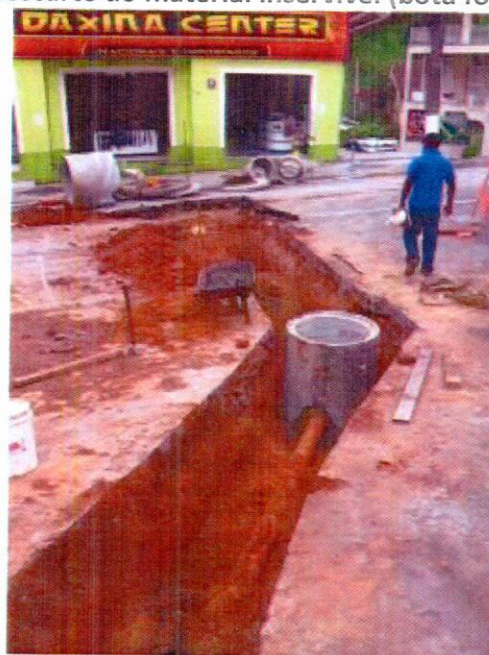
30. 18/03/15 – Execução de P.V.
