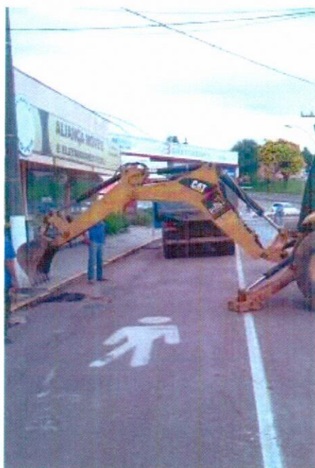
35. 19/03/15 - Remoção de asfalto para execução de ligação domiciliar
