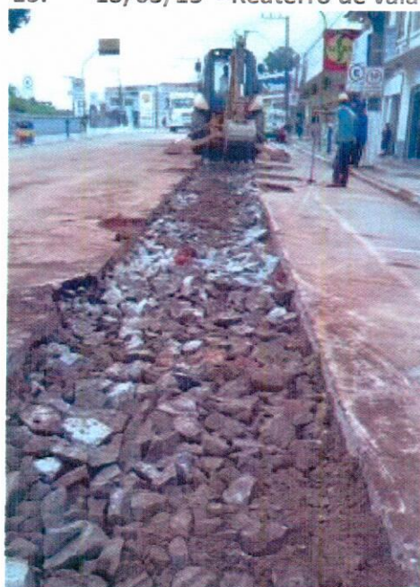
17. 13/03/15 - Recomposição do pavimento
