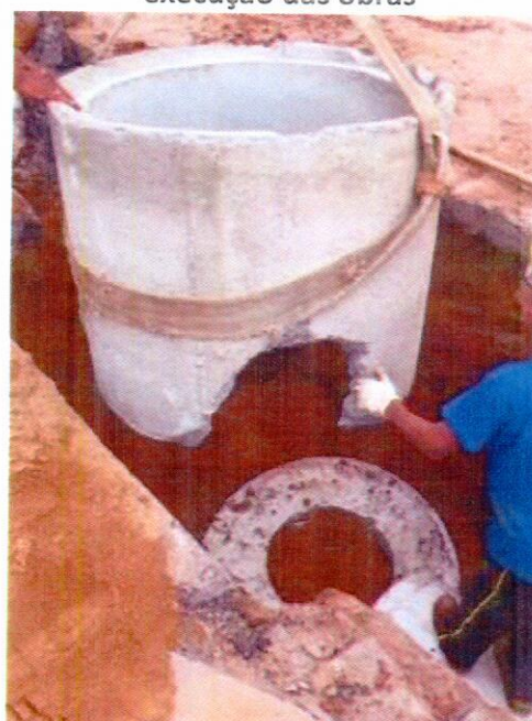
26. 17/03/15 – Execução de P.V.
