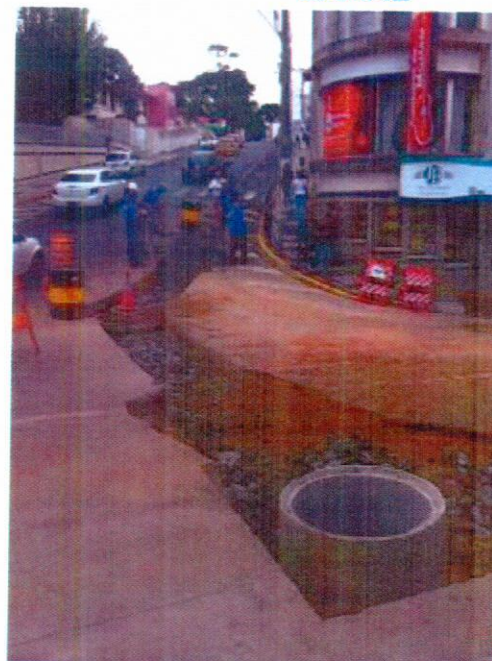
32. 18/03/15 – Vista do local das obras
