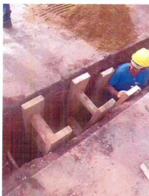
42. 26/03/2015 – Vala escorada com pontaletes de madeira
