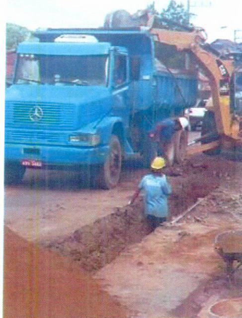
46. 31/03/2015 – Escavação mecânica de vala
