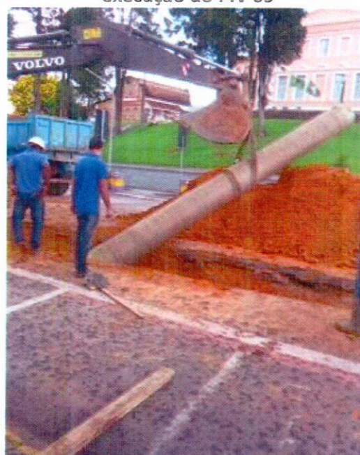
06. 11/03/15 - Assentamento de tubos
