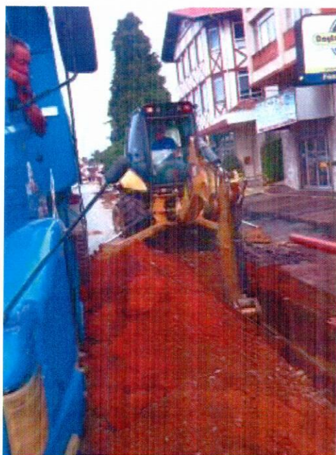
51. 16/04/15 – Escavação mecânica de vala
