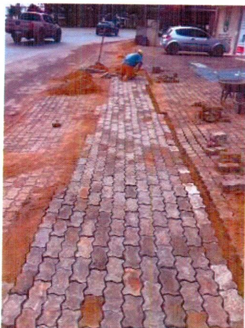
55. 17/04/15 – Recomposição de calçada em paver
