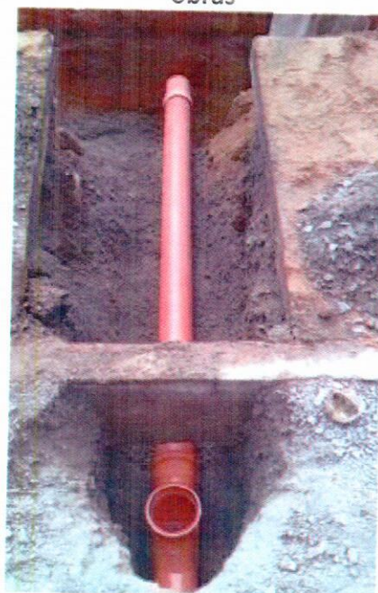
50. 16/04/15 - Execução de ligação domiciliar
