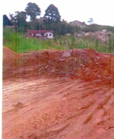
28. 17/03/15 – Vista do terreno de descarte do material inservível (bota fora)
