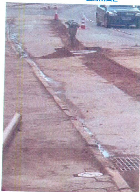
48. 31/03/2015 – Vista do local das obras
