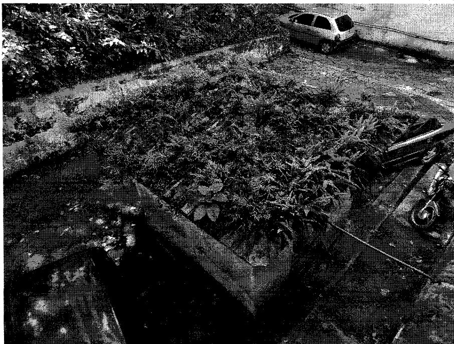
Foto 4: Fundos – Anexo com vegetação na cobertura.
