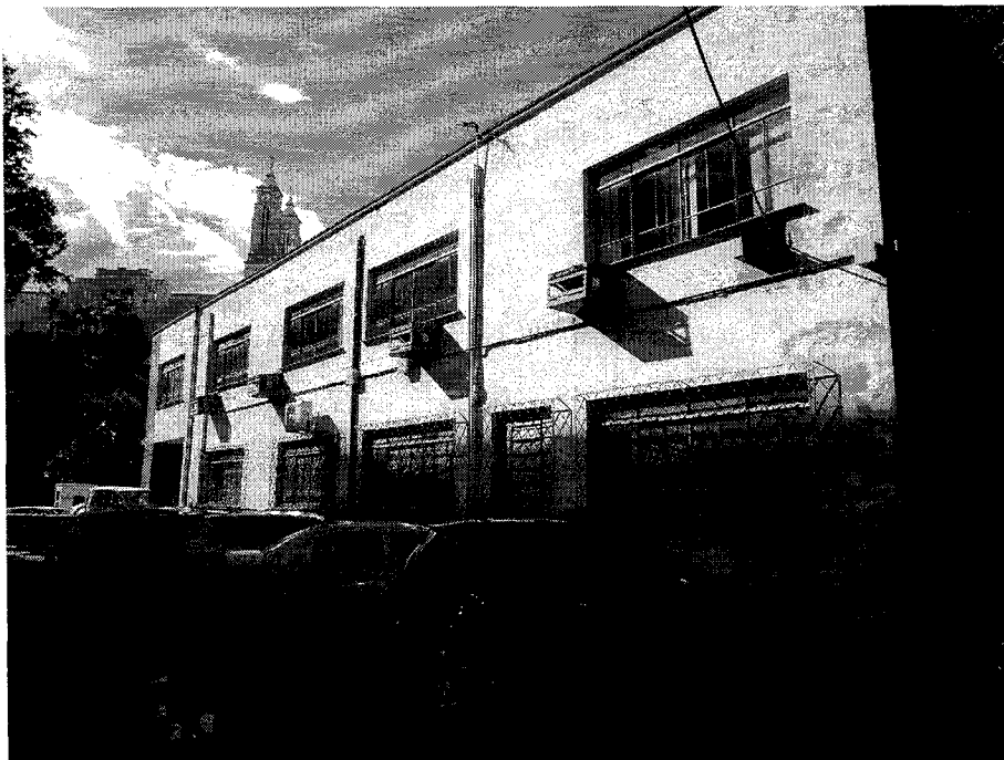
Foto 3: Fachada lateral direita – Reboco e pintura danificados, instalações elétricas externas.
